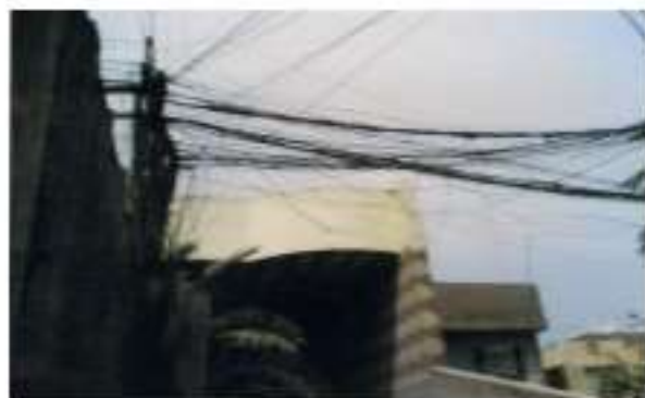
صورة (8) تشابك اسلاك خطوط نقل الكهرباء للوحدات السكنية كما تظهر سيارة تزويد الوقود للمولدة الكهربائية المشتركة سنة 2009م
