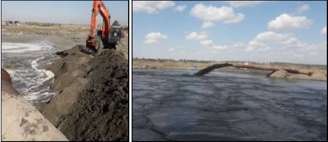
صورة (١) الرواسب المستخرجة من مقدم السدة صورة (٢) احواض الترسيب عند سدة الهندية
